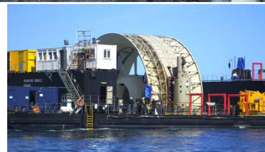
Hydrolienne Open Hydro sur la barge d'installation
